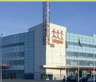
Telekomunikāciju infrastruktūra „Arēna Rīga”
